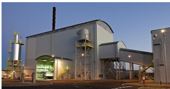
Figura 7: Planta BIOMASA MIAJADAS, S.L, situada en Miajadas.
