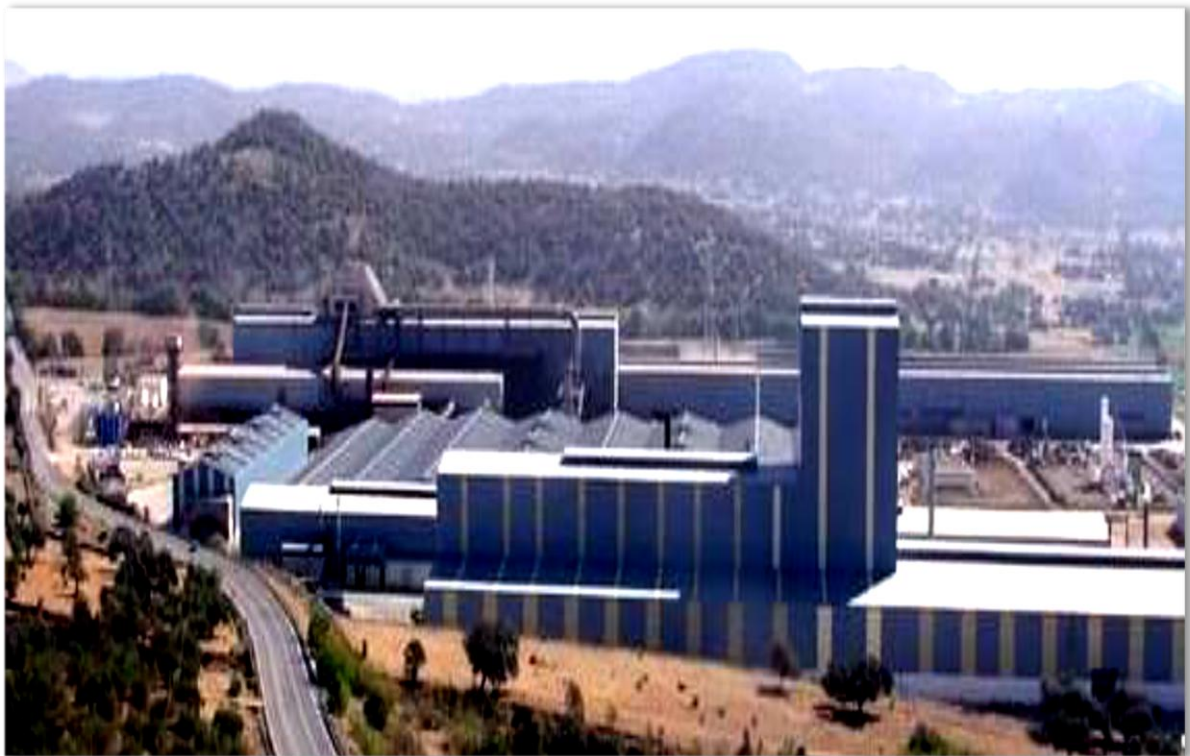
Figura 8: Instalaciones de AG Siderúrgica Balboa S.A. en Jerez de los Caballeros.
