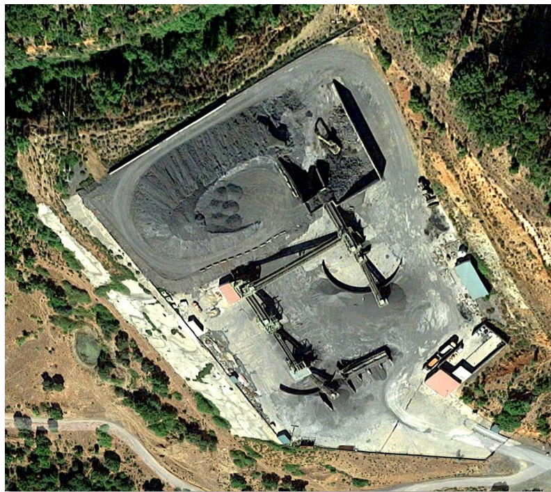
Figura 9: Planta de tratamiento de escorias negras, situada en Jerez de los Caballeros.
